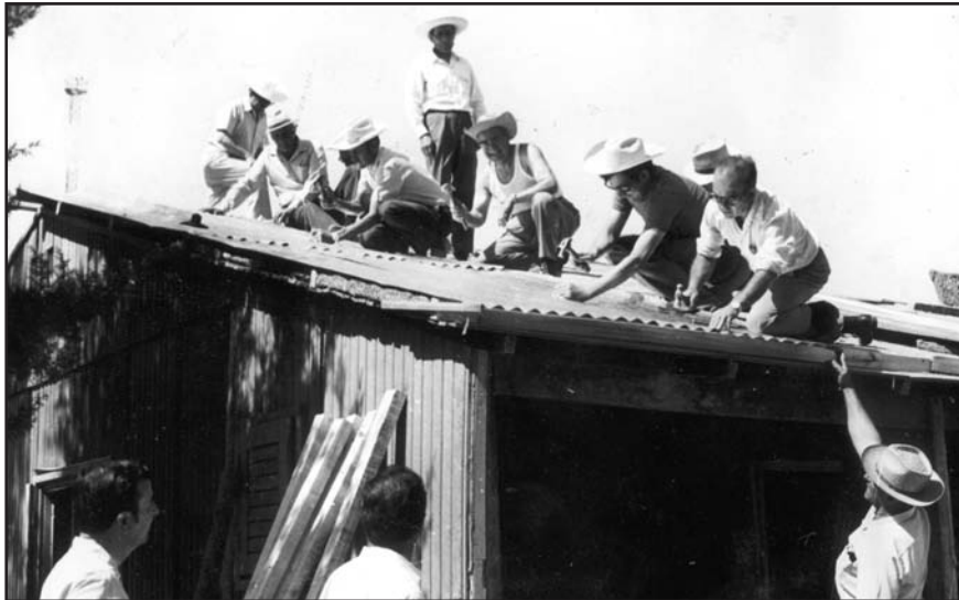
1971 - El Rotary Club La Consulta, dona las chapas y realiza la colocación e instalación del techo completo.
